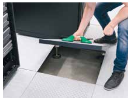
Idealer Doppelboden mit Luftauslässen auf Bedienseite der Racks, ansonsten sauber verschlossen
