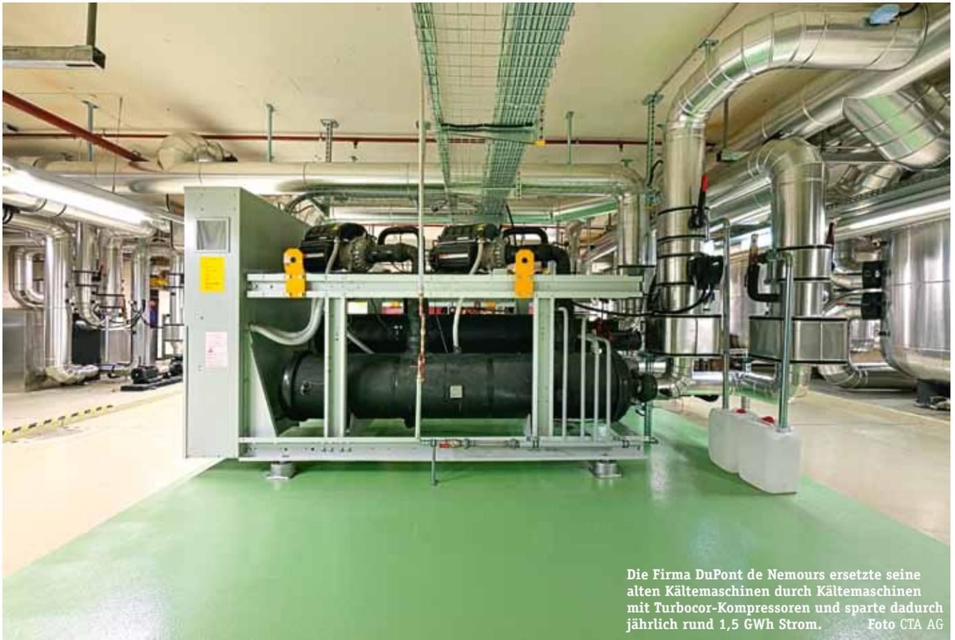
Die Firma DuPont de Nemours ersetzte seine alten Kältemaschinen durch Kältemaschinen mit Turbocor-Kompressoren und sparte dadurch jährlich rund 1,5 GWh Strom. Foto CTA AG
